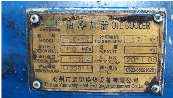
Hình 5. Thông số kỹ thuật của kết làm mát dầu thủy lực hiện tại của tời thủy lực JKYB.
